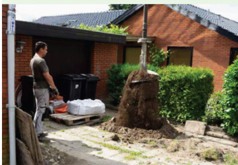
Boring af det andet hul i op til 5 meters dybde.
