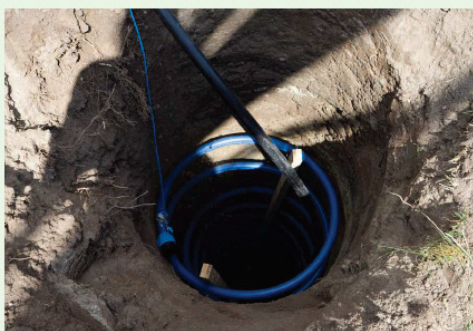
Spiralen klar til at tilslutte.
