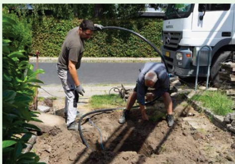
Jordvarmespiralen er monteret perfekt i hullet.
