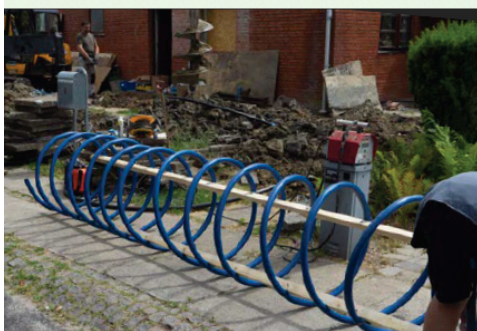
5 meter spiral klar til montage.
