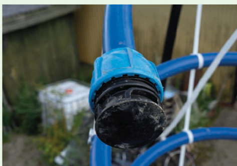
Spiralen monteres til jordvarme-anlægget.
